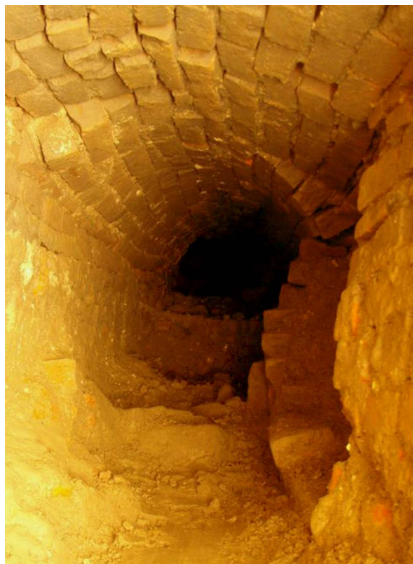
Foto 7 Boční stěna barokní kanalizační chodby pod j. ambitem se stářím vyvaluje (foto Marek Gyaneshwarpuri, 2008).
