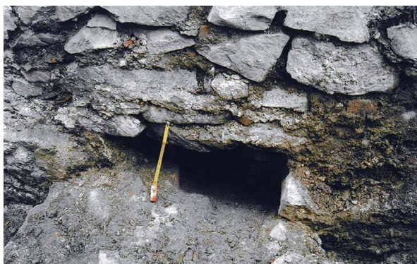
Foto 1 Objevný otvor do Chodby pod s. ambitem (foto Marek P. Šenkyřík, 2005)
