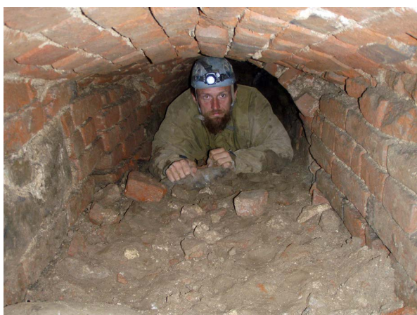
Foto 3 Vstupní chodba do Pozemního systémku pod j. ambitem (foto Marek Gyaneshwarpuri, 2008)
