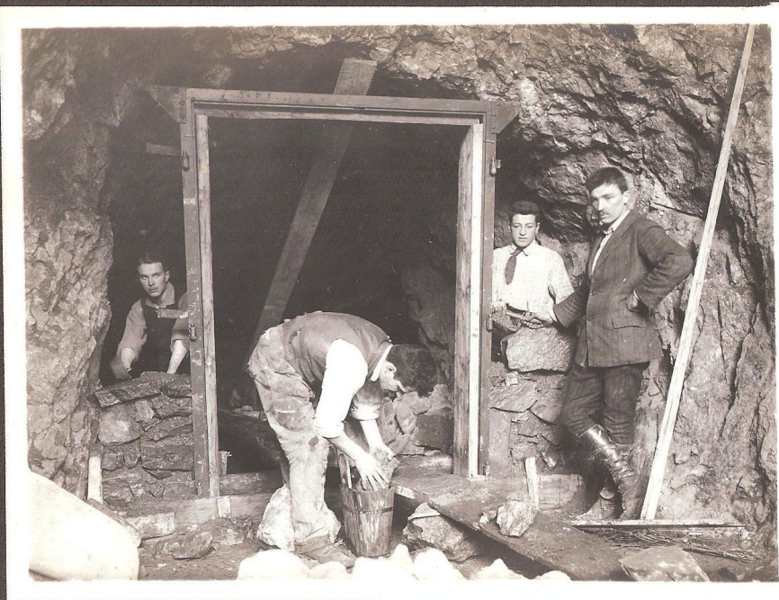
instalace rámu vchodové mříže
