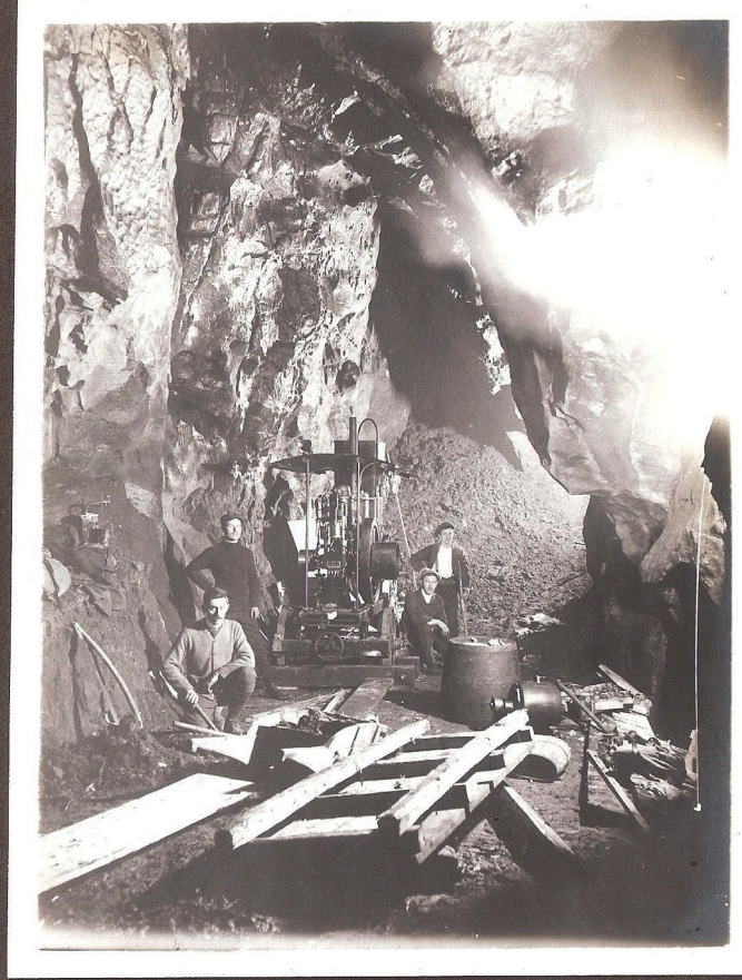
doprava dieslova motoru a kom- presoru do prostoru Prstu u Genkova sifonu
