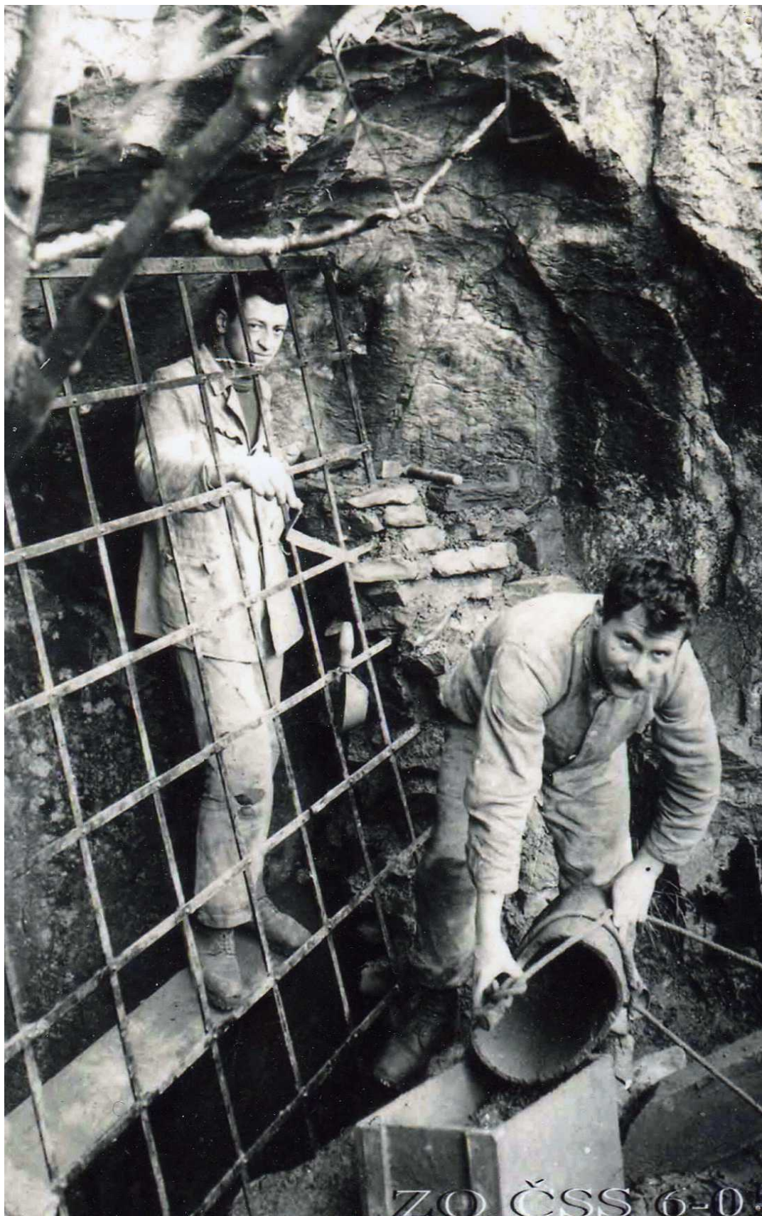
Zabezpečení skalního okna vzděním mříže
