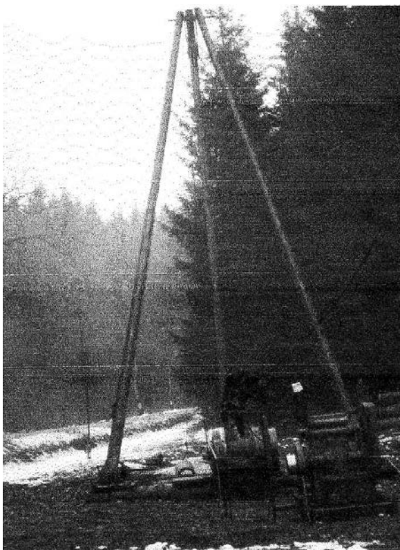
Zahájení vrtných prací na hloubení hydrogeologického vrtu. Orig. foto R. Cendelín, 5.12.1971
