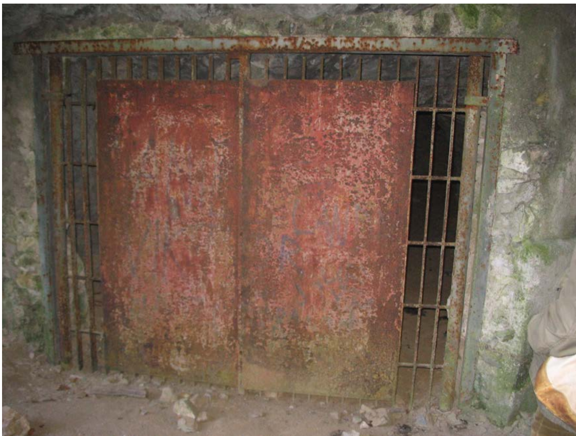
Před námi jsou mřížová vrata – uzávěra pro výtok povodňových vod.
