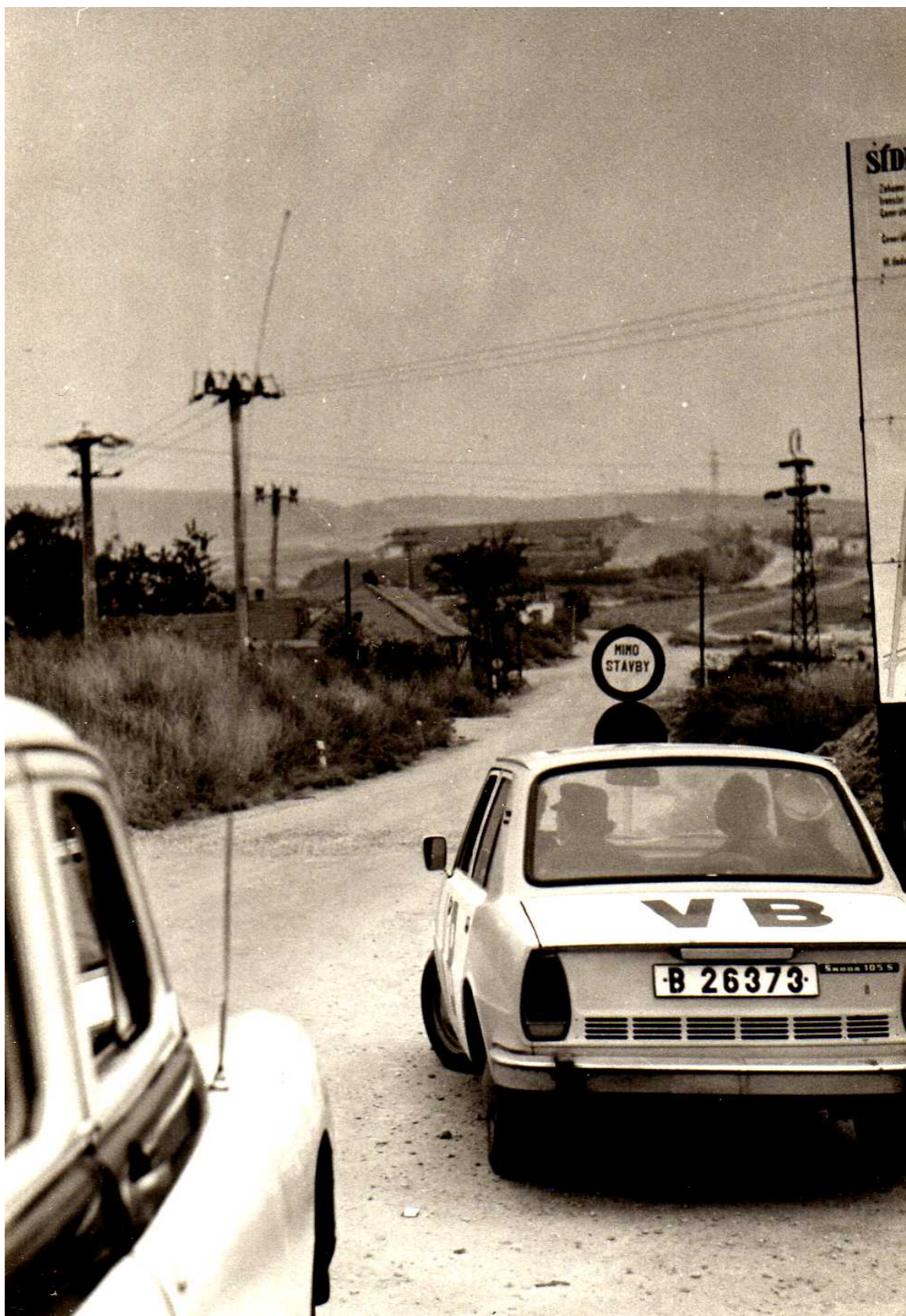
Na tomto snímku Z. Trnky, pravděpodobně z r. 1969 vidíme, že větší část Růženina dvorku je již zbořena, začínají se provádět terénní úpravy pahorku, rokle dávného koryta řeky je už zavezena, silnice je uzavřena pro provoz a zatím slouží jako zařízení staveniště nového líšeňského sídliště. Vykácením vegetace je tato silnice směrem na pahorek již obnažena. Mizí a mění se krajina, kterou jsme znali.
