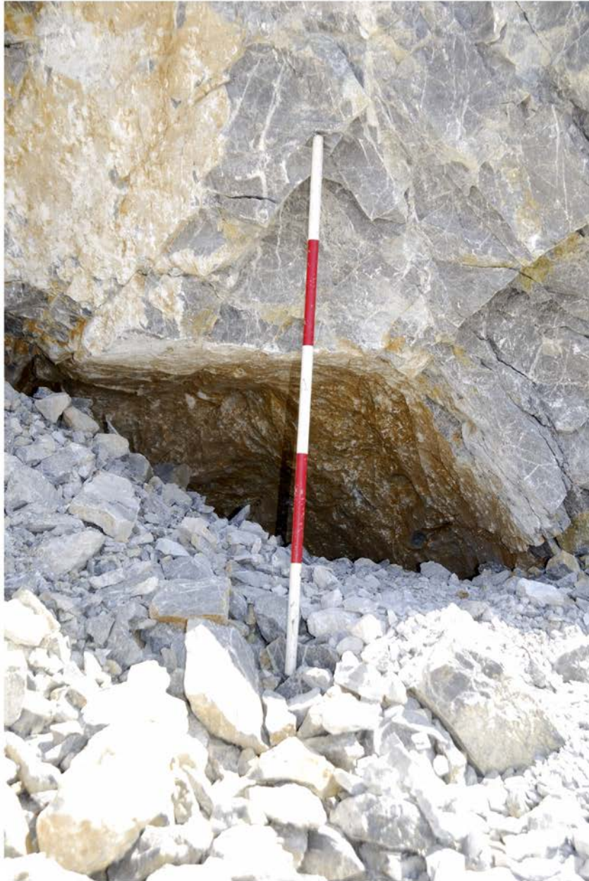
Západní lom. Část chodby j.č. 0072
