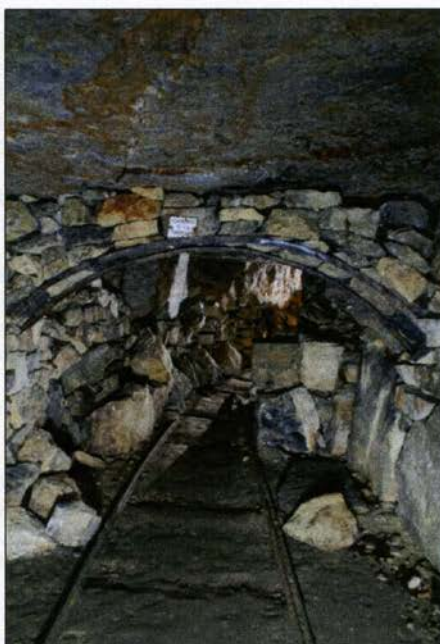
Obrázek 5. Podzemí Moskvy (foto Harna)
