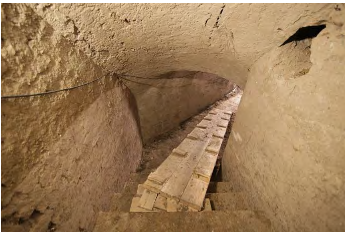
Pohled při sestupu do sklepa.
