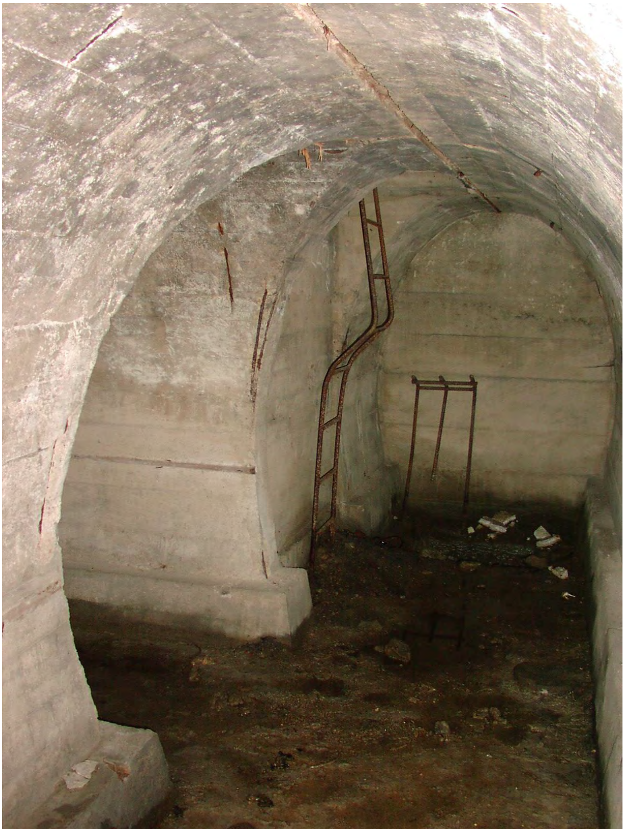
Kovový žebřík z jednoho z nouzových výlezů – nyní jediné možnosti, se ještě do krytu a k jezírku dostat...
