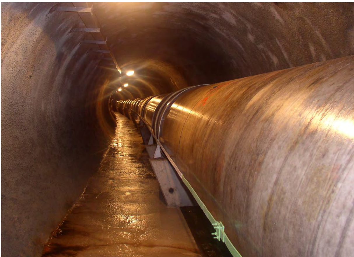
A zase 4 km zpátky štolou k Bystři... Z mírného kopečka se jde příjemněji, je to taková meditace v chůzi, je tu ticho a příjemně vlhčí vzduch všemi průsaky skrze torkretovou klenbu.
