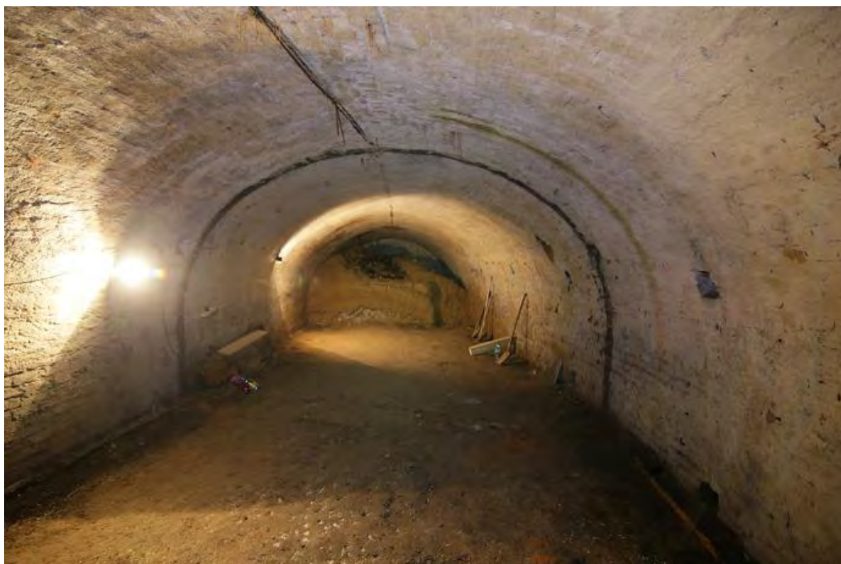
Fáze ještě před úplným vyčištěním sklepa – počátek prosince 2016
