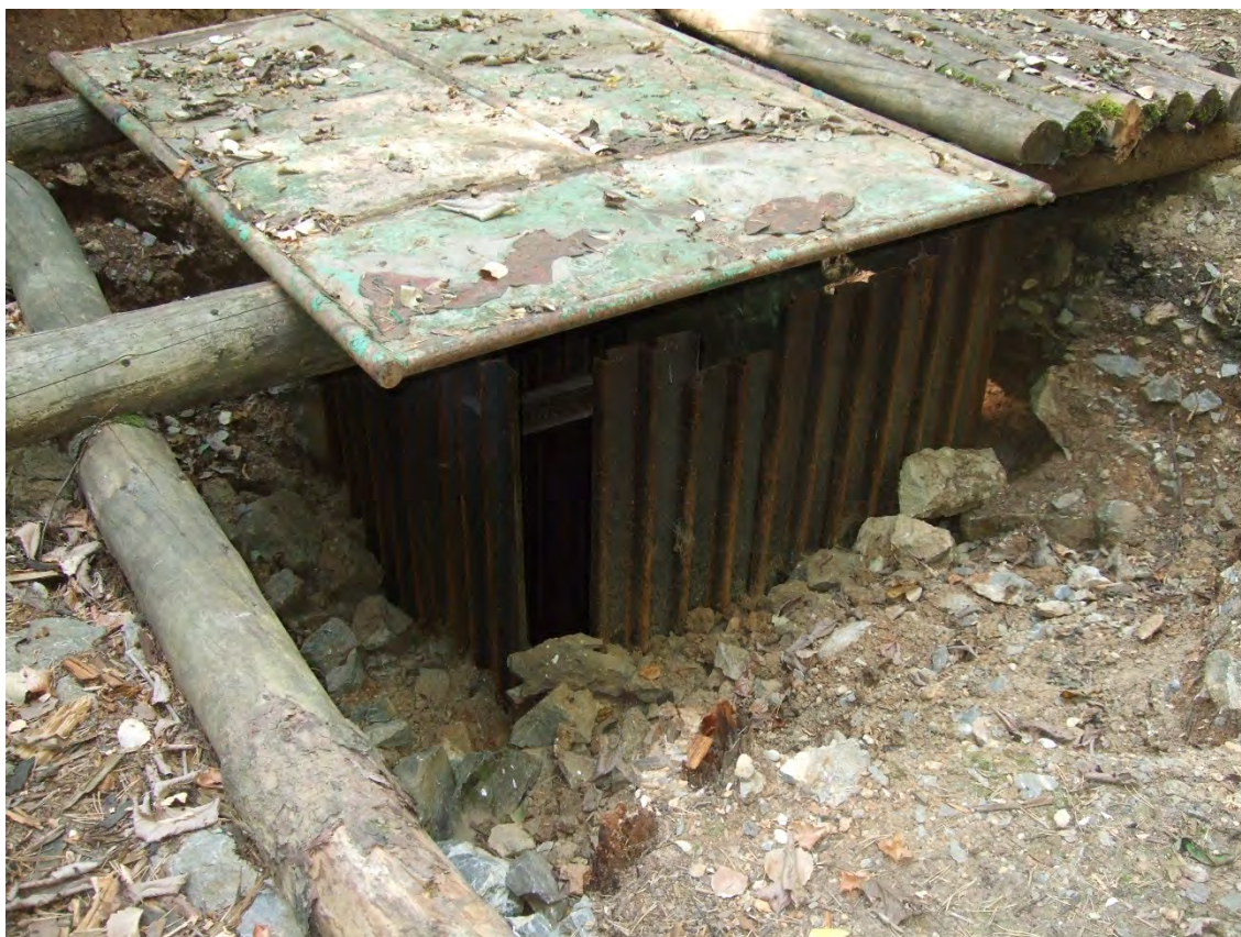
Obrázek nahoře : Výzkumná šachta ZO 6 – 12, vyztužená ocelovými larseny.
