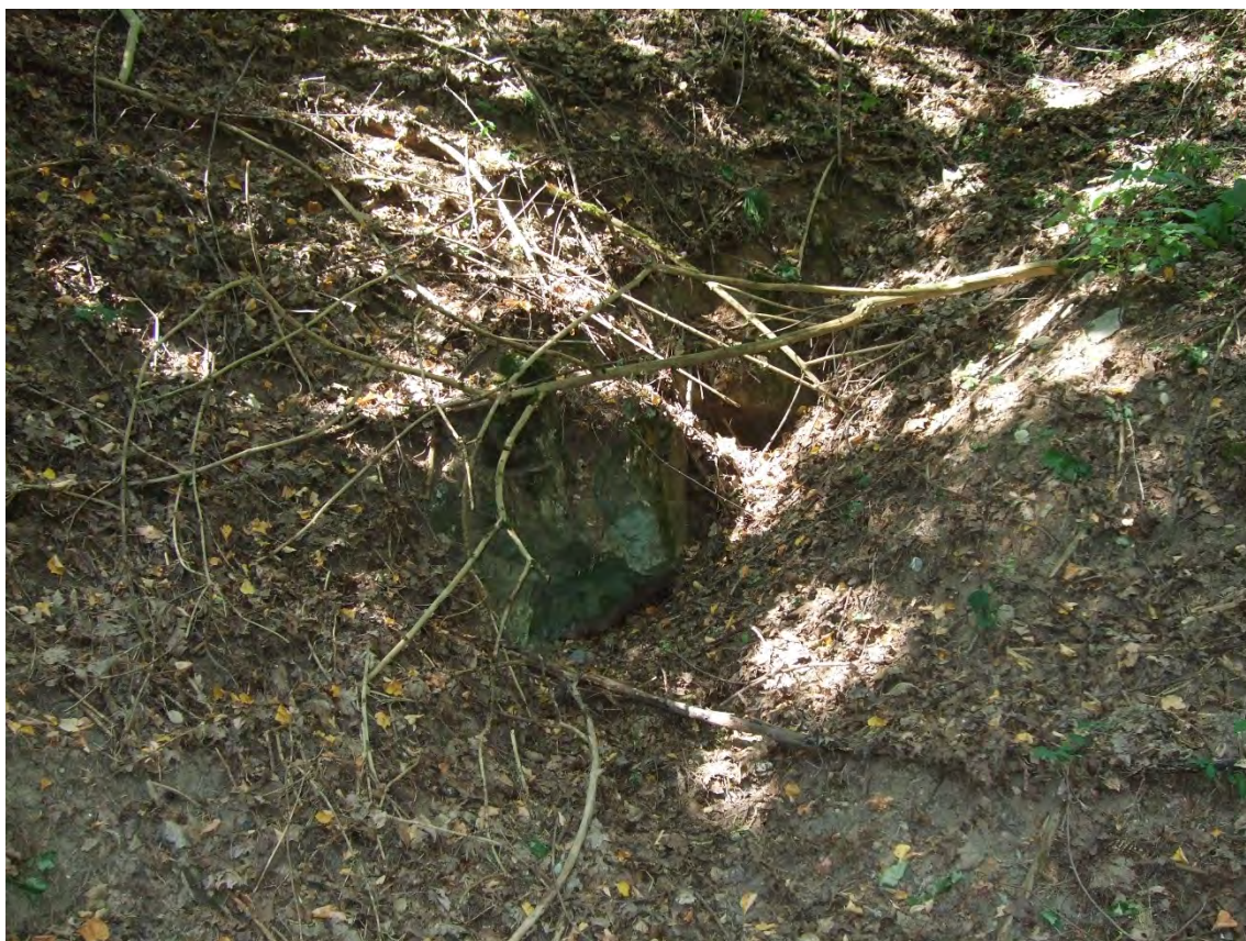
Detailní záběr Propadání Hostěnického potoka II. (Stav dne 22.08.2018)
