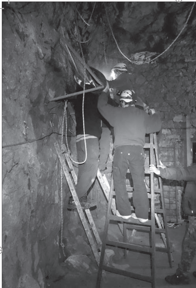
Foto 3 Montáž ochranné gumy na hranu umělého převisu (Foto V. Bláha)
