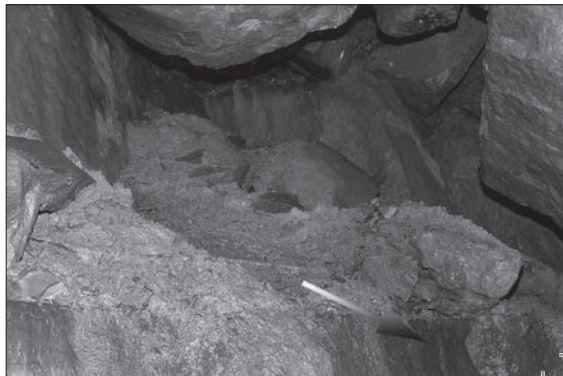
Foto 3 Rozvolněné podloží – místo sesuvu skalních bloků (Foto J. Wagner)
