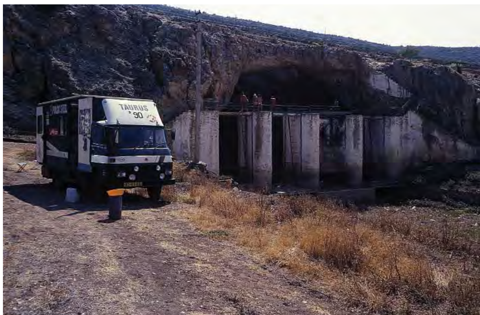
Mohutný ponor Karagöl Düdeni je obrovitý hltač vody odvodňující celou plochu polje. Ústí jeskyně s překrásným přírodním mostem je přehrazeno betonovou hrází s propustmi.
