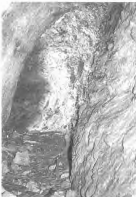
Obr. 2. Čelba štoly – z tvaru stropu je dobře patrná ruční těžba.
