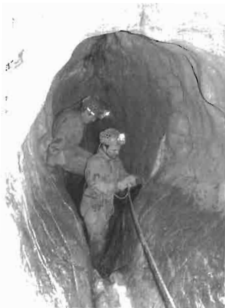
Foto 7. Nová Rasovna, odstrojování a vynáška materiálu (foto R. Zatloukal).
