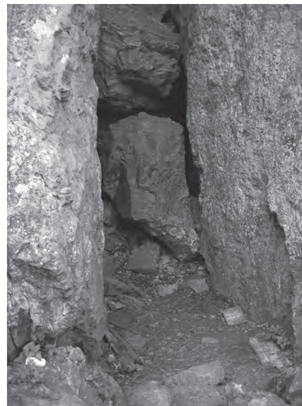
Obr. 1: Současný stav vstupu do šachty za Evropou a Indií. Foto: F. Musil, 2006.
