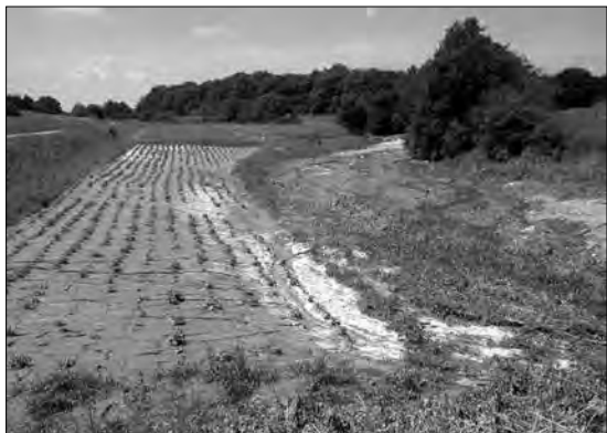
Fig. 9 Petrovický žlíbek below the confluence point of the Petrovický and Žďárský creeks at the end of May, 2003
