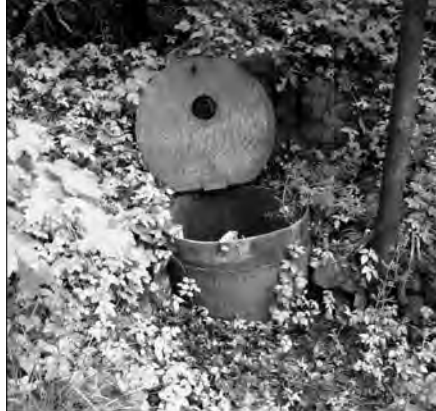
Foto 1 Nový vchod zabezpečený železnou trubkou (Foto Z. Cihlář)
