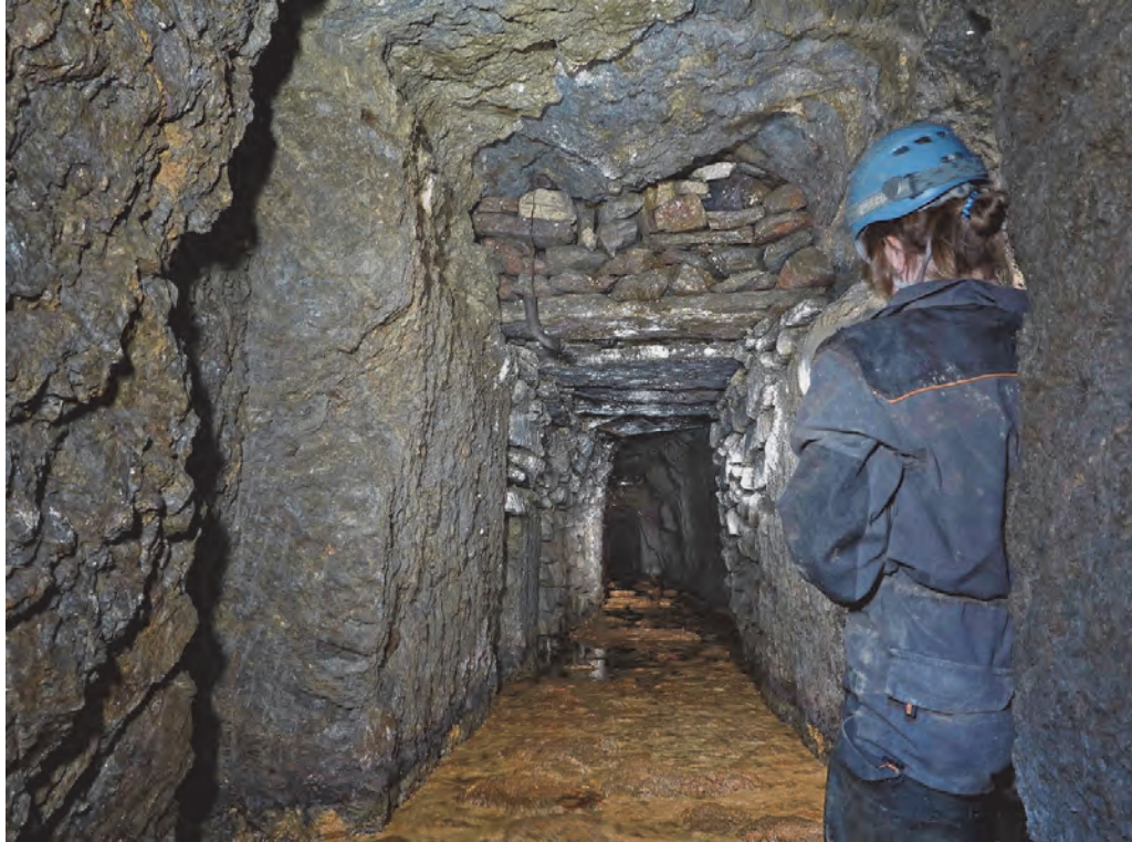
3. Profil štoly v úvodní části při pohledu od ústí, foto Tomáš Janata, 2013.
