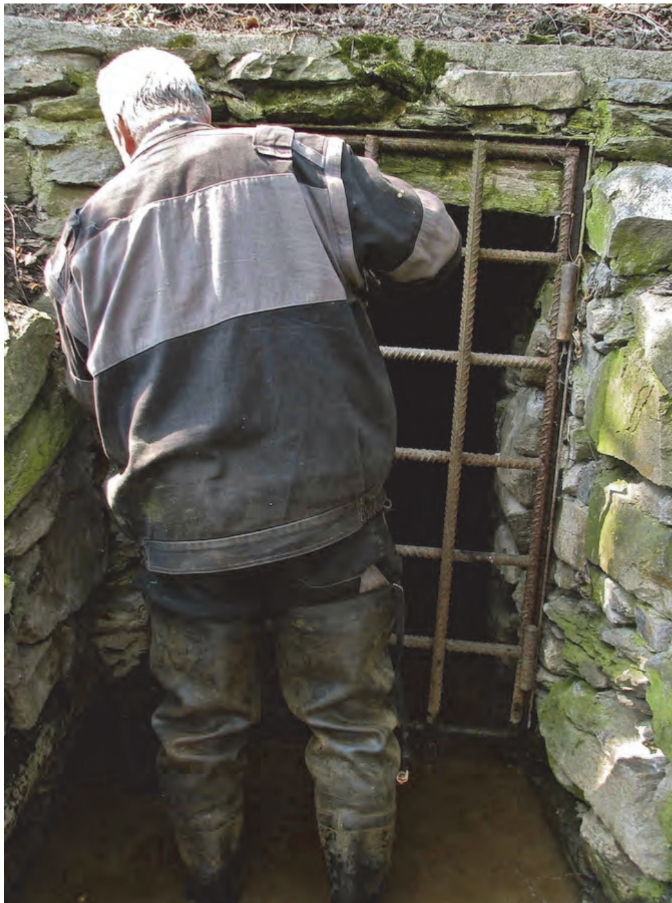
2. Portál štoly z r. 2001, zhotovený firmou Geoindustria a osazený uzamykatelnou roxorovou mříží, foto Tomáš Janata, 2013.
