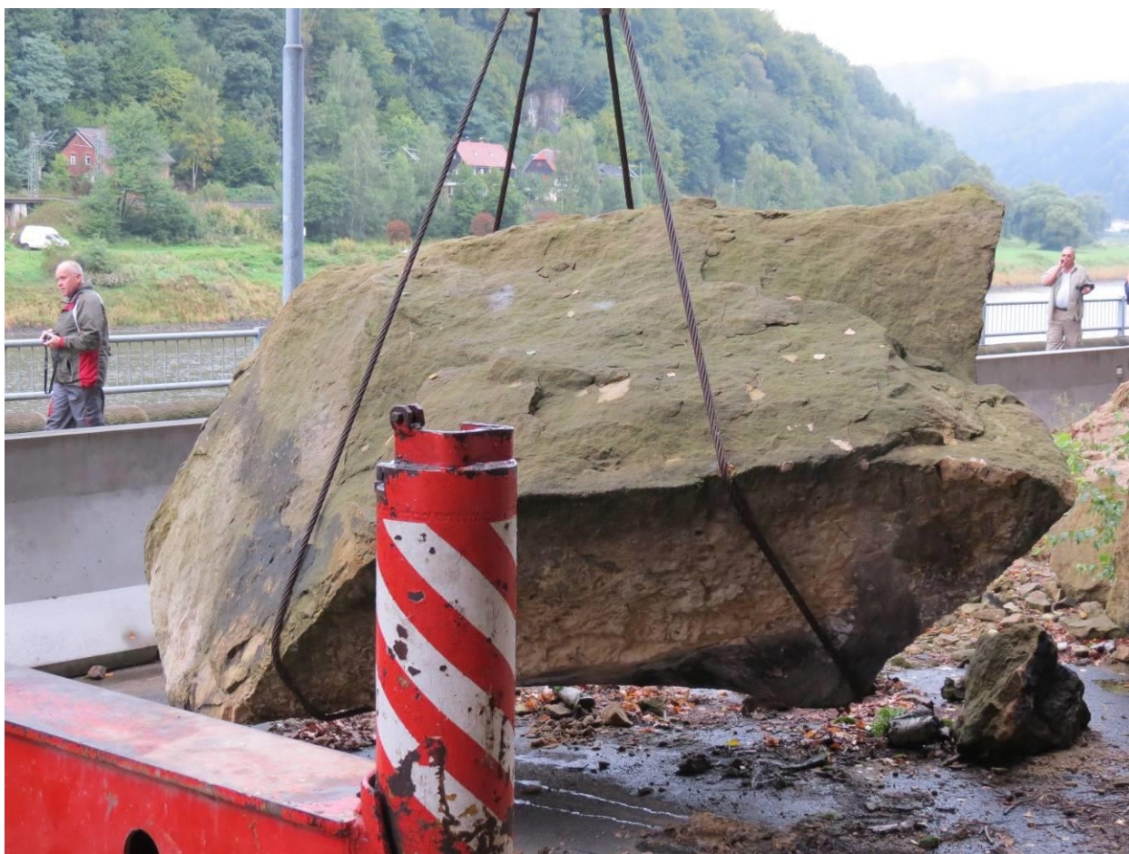
Obr. 1: Odvoz balvanu zříceného na silnici I/62 na podzim roku 2009
