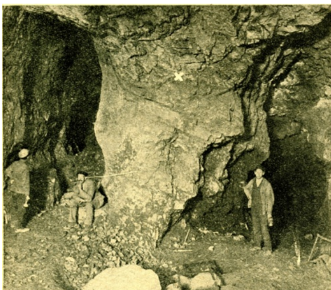
Obr. 2 Unikátní historický snímek ukazující mocnost těžené vrstvy fosfátových hlín ve Výpustku (označení původního povrchu křížkem). Všimněte si různé koroze povrchu vápencové stěny nad sedimenty a v sedimentech (Frodl 1923).
