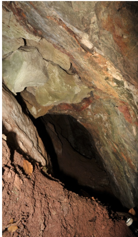
Obr. 5 Pravou (jižní) stěnu tvoří brekcie, strop zkrasovělá poloha krystalických vápenců se zaklíněnými balvany (Foto R. Tásler)
