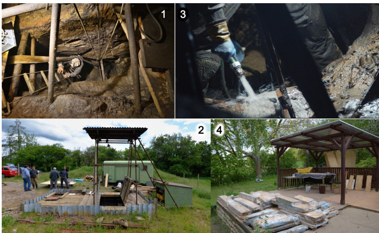
Obr. 5 Přístup do hloubení a manipulace s díly ventilátoru: 1 – sestup do hloubení na úroveň pracovního povalu, 2 – šachta č. 1 s vrátkem, 3 – rozplavování sedimentů proudem vody, 4 – složené díly větráku na základně ARÚ v Bylanech (Foto M. Přibil, K. Šmehil (1, 2), O. Malina (4), foto z kamery GoPro M. Souček (3))
