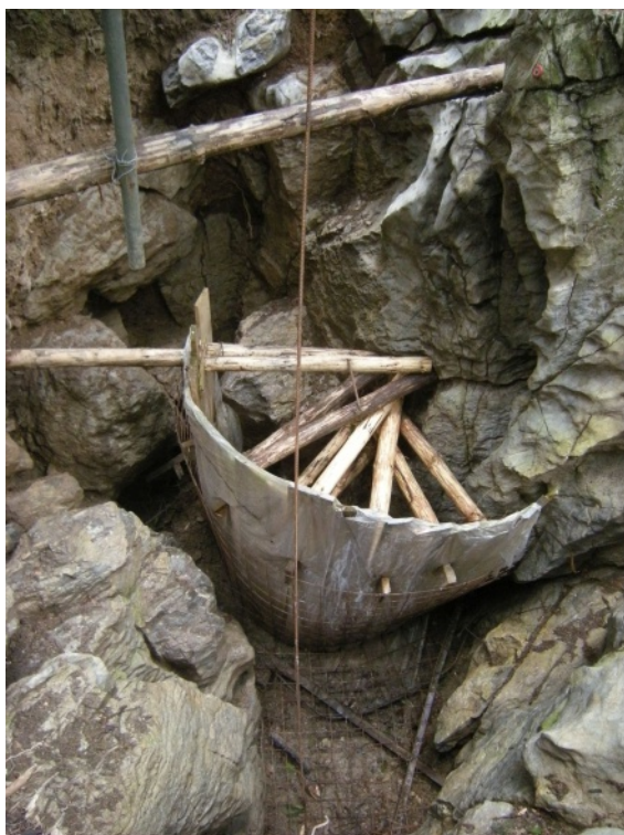
Foto 7 Děravka připravena na betonování vchodu, k němuž však již nedošlo.
