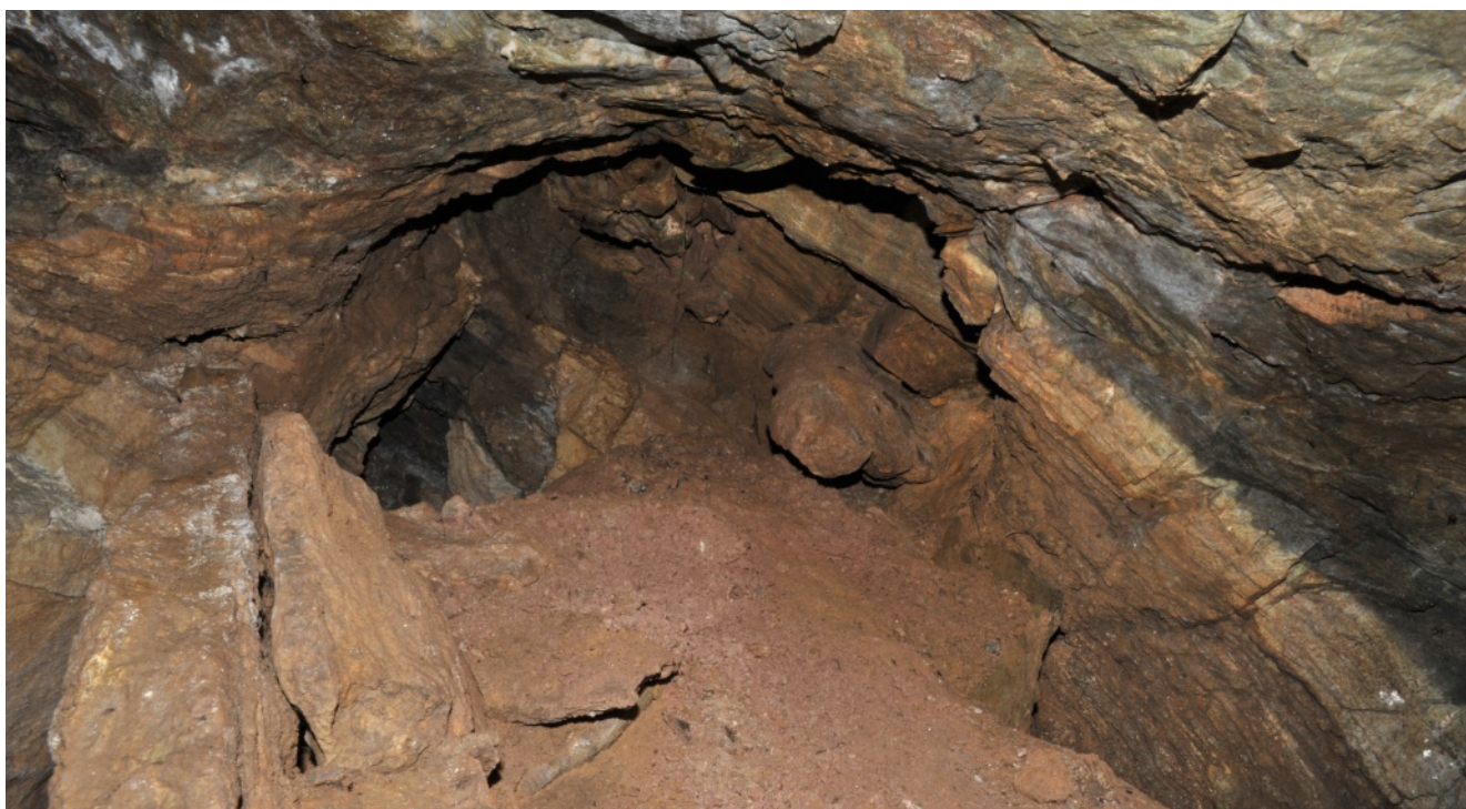
Obř. 3 Zadní část štoly s vysypaným materiálem z krasového komína (Foto R. Tásler)
