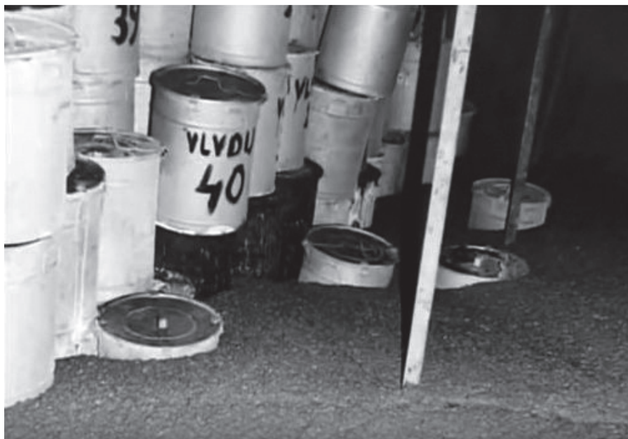
Foto 7 Zalévání betonovou kaší
