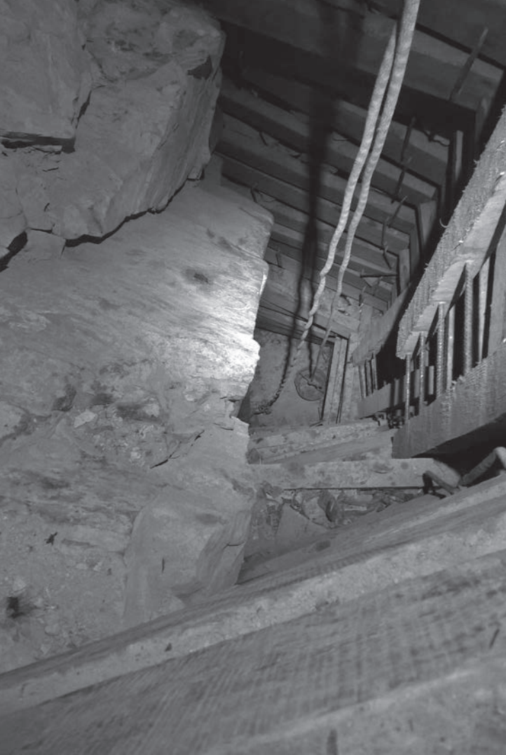
Foto 1 Pohled do šachty (Foto J. Kunc)
