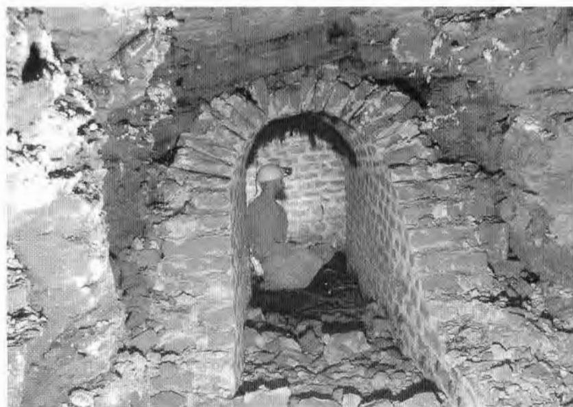
Josefov – vybouraná vyzdívka z minové chodby. Na snímku je patrné, že chodba byla ražena ve skalním masivu – ve vápnitých slinovcích – „opukách“ (foto R. Tásler).
