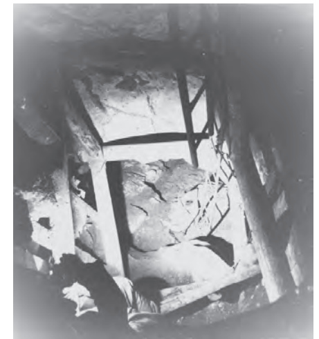
Obr. 3: Dno šachty s ústím korozí rozšířené vrstevní spáry. Foto: J. Vít.
