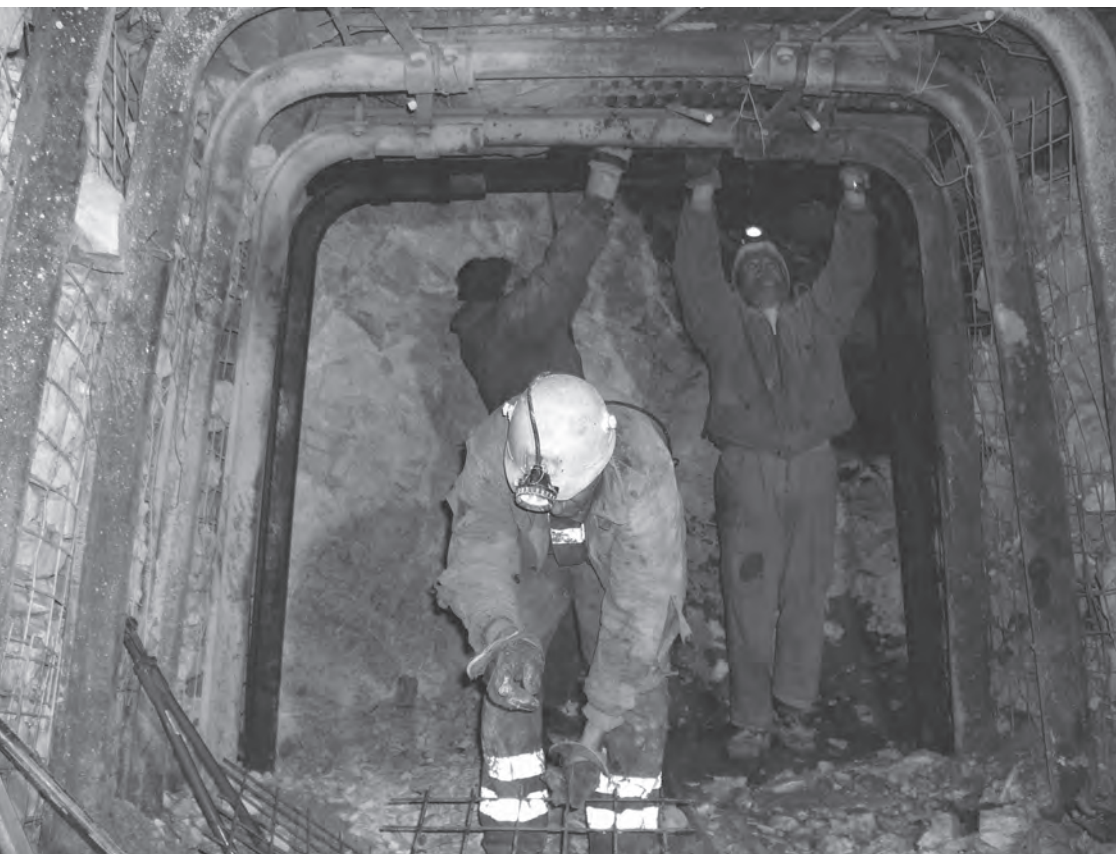
Instalace TH výztuže v nové štole. Foto: Archiv Správy Chýnovské jeskyně.
