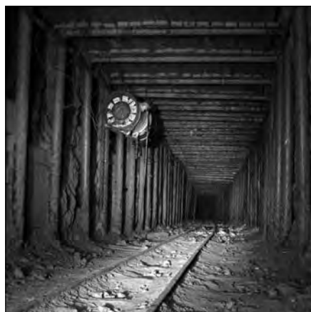
Obr. 15 Tramvajová štol
