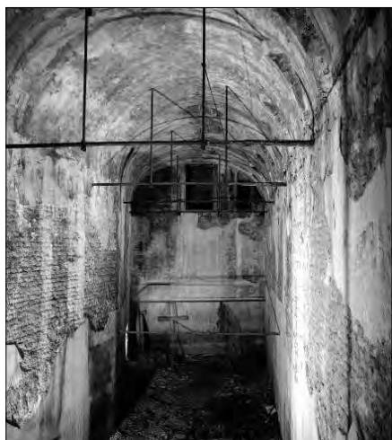
Obr. 9 Vyprázdněný vodojem na Puhlíku, dnešní stav
