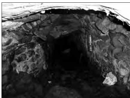
Foto 2 Stará lázeňská štola, zaklenutí původního výtoku důlních vod na povrch pod Tržním náměstím (Foto P. Chaloupka)
