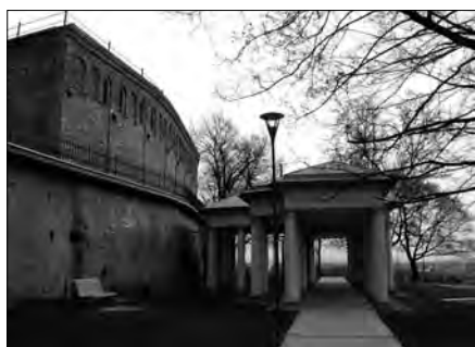
Obr. 8 Vodojem na Puhlíku, exteriér
