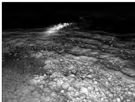
Obr. 17 Tramvajová štola, podlahový sintro s hrázkami
