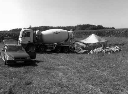
Foto 6 Betonáž podesty s první skruží (Foto F. Doležal)
