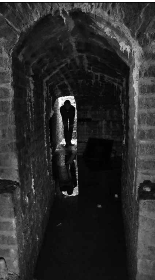
Foto 2 Pohled ke vstupní šachtě (Foto J. Kukla)
