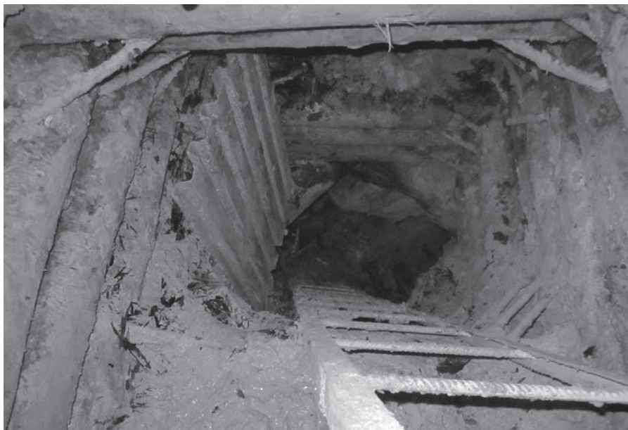
Foto 2 Původní výdřeva (Foto V. Bláha)
