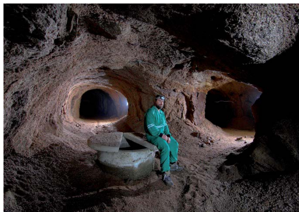
Obchod kolem nevybudované protivýbuchové hráze severní vstupní chodby podzemní továrny FAB. Foto: Martin Přibil.
