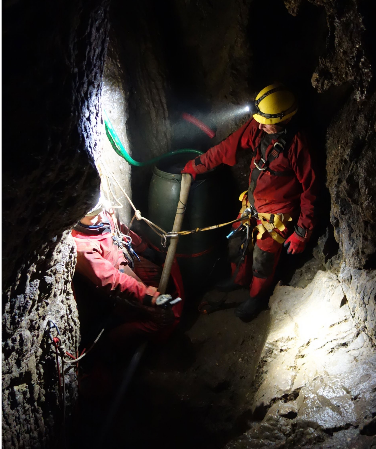
Foto 3 Přecherpávací stanice pod mezipatrem (foto V. Bláha)
