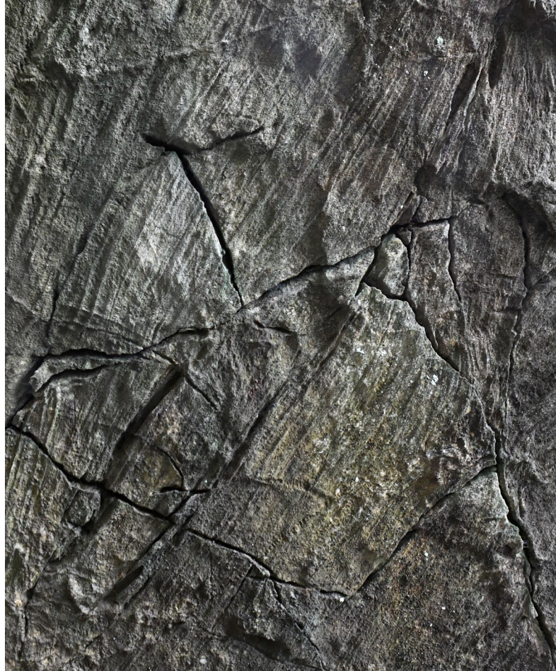
Foto 3 Korozí rozšířené pukliny a vyvětrané foliační plochy v ploše poruchy 212/85 a jižním boku dobývky (foto R. Tásler)
