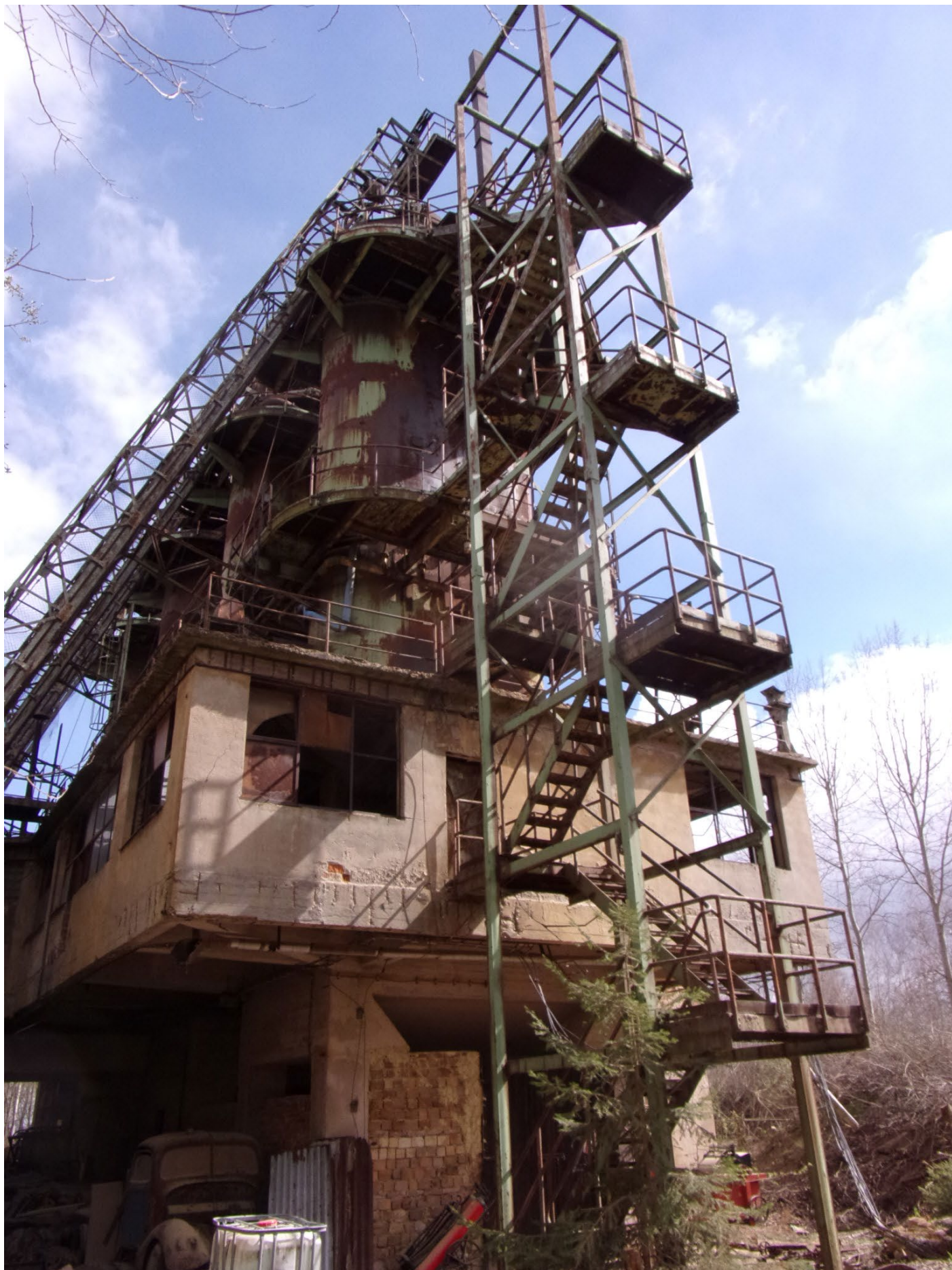
Foto 4 Schodiště k výstupu na pece, duben 2025 (foto Dušan Kleberc)
