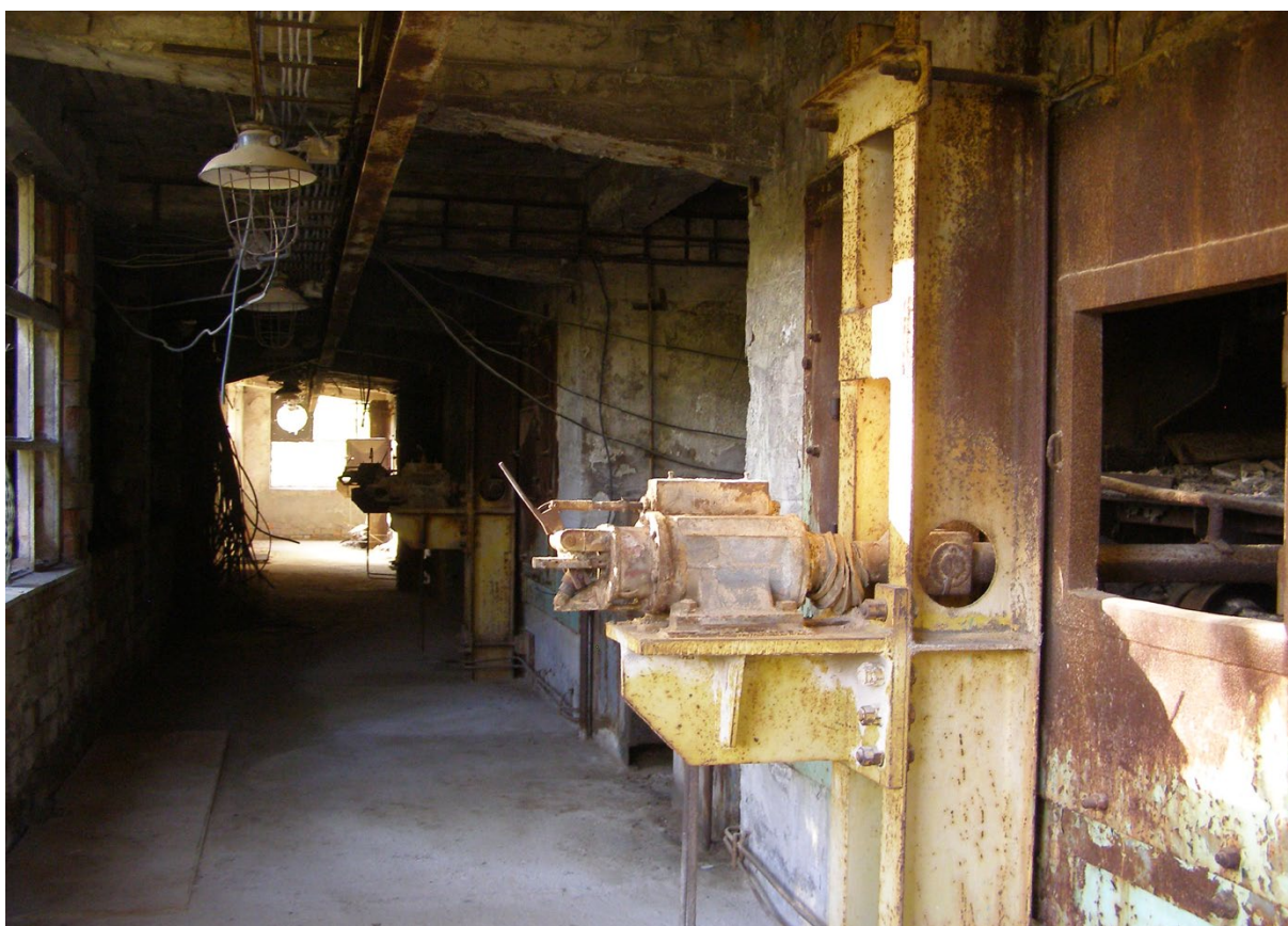
Foto 7 Pohled dovnitř pecí na rošty, vnitřek betonového patra, říjen 2024 (foto Pavel Kolínský)
