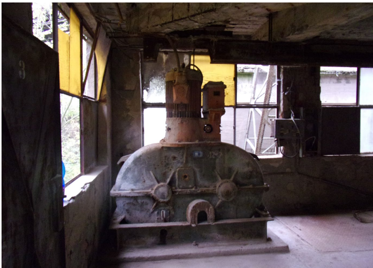
Foto 6 Motor skipového výtahu, vnitřek betonového patra, říjen 2024 (foto Dušan Kleberc)
