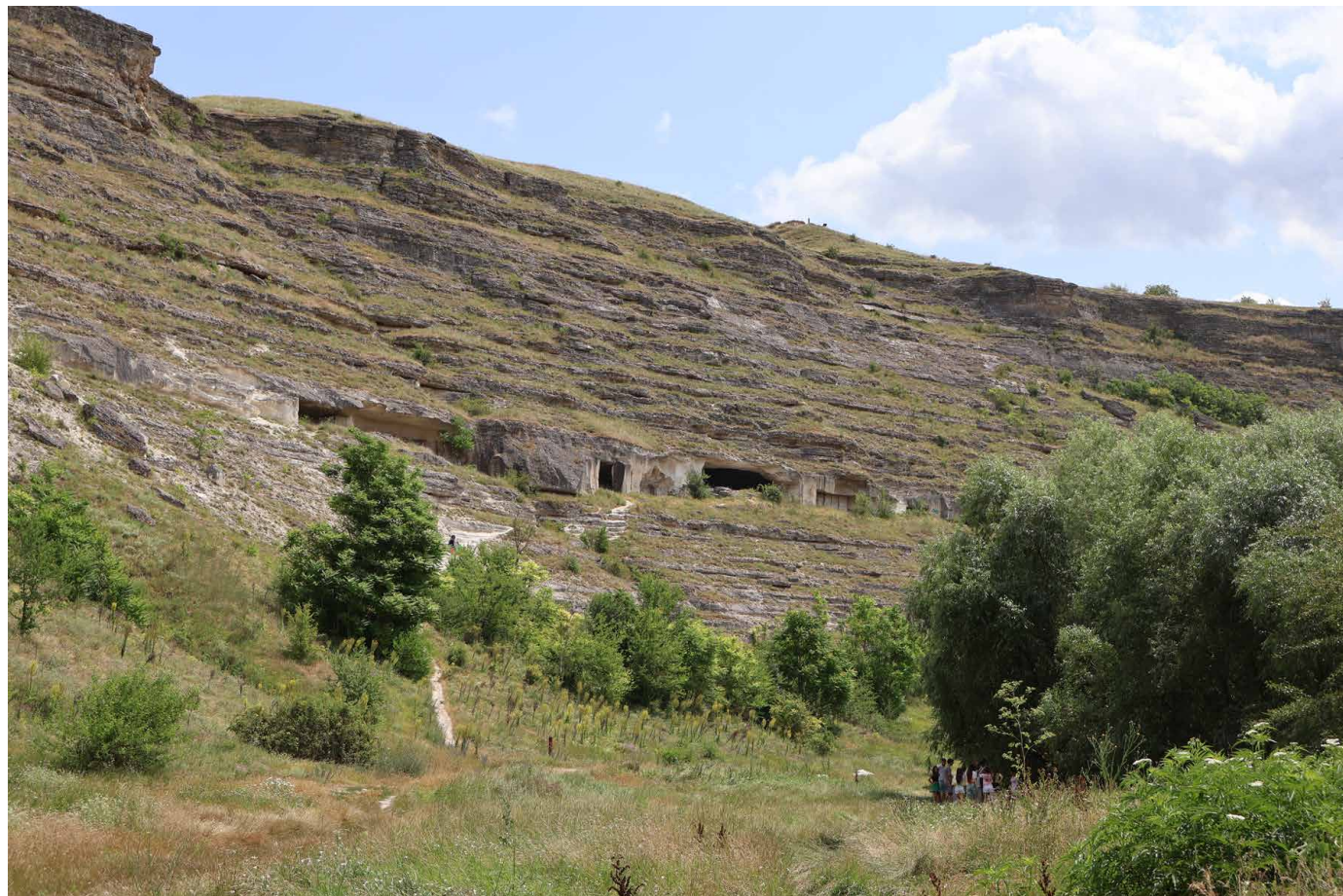
Obr. 6 Pohled k těžebním komorám u Trebujeni (foto M. Hejna).
