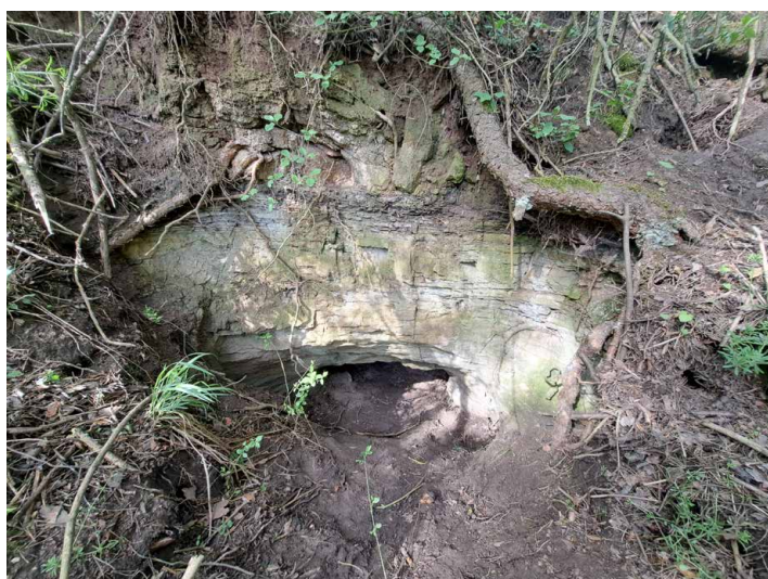
Obr. 1 Vstup do štoly je poměrně nízký, nalevo je jezevčí nora (foto M. Majer).
